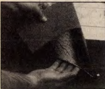
16. ábra KATEPAL zindely rögzítés és az átfedés
